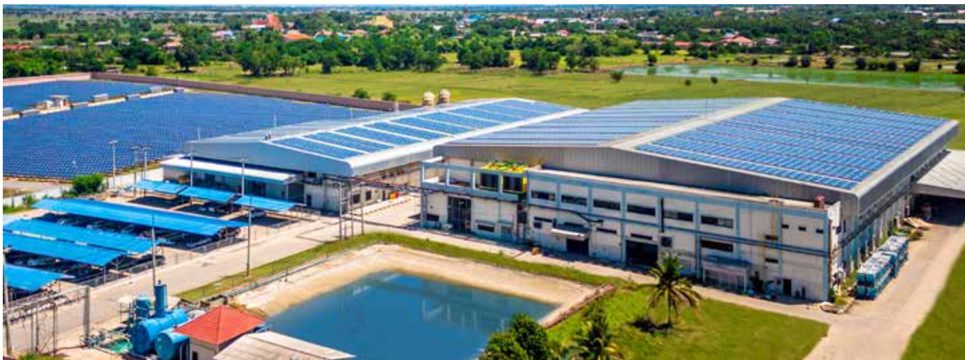
Solar roof project on the roof of the Indorama Holdings buildings and the PETFORM buildings. โครงการผลิตไฟฟ้าพลังงานแสงอาทิตย์แบบติดตั้งบนหลังคา ของโรงงาน อินโดรามา โฮลดิ้ง และ โรงงานบริษัท เท็ทฟอร์ม
