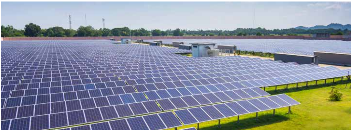
Solar farm, a ground mounted system โรงไฟฟ้าพลังงานแสงอาทิตย์ “โซลาร์ฟาร์ม” (ติดตั้งบนพื้นดิน)
