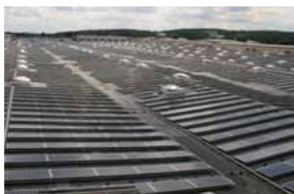
▲ แผงโซลาร์เซลล์ที่ติดตั้งในบริษัท Trevira
