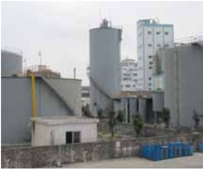
▲ โรงงานบำบัดน้ำเสียแห่งใหม่ของบริษัท Guangdong IVL ประเทศจีน
