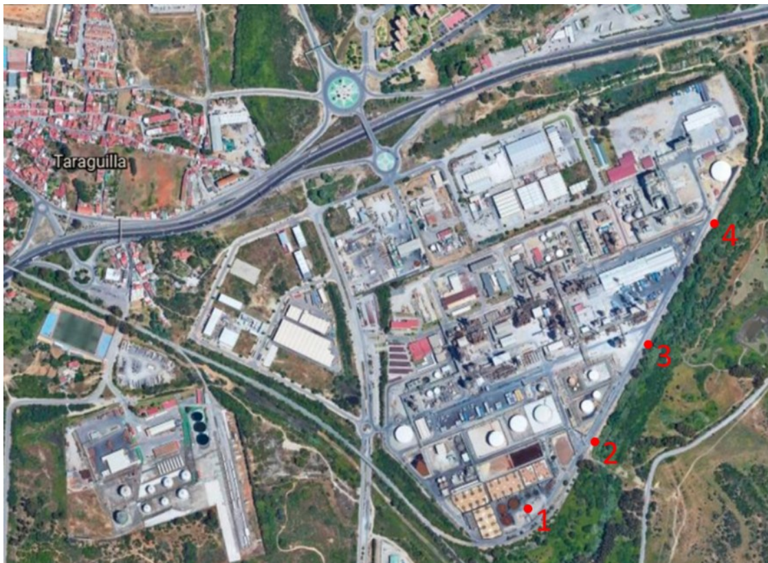
Ilustración 7. Ubicación de los puntos de vertidos de Indorma Ventures Química, S.L.U. Fuente: Google Earth
