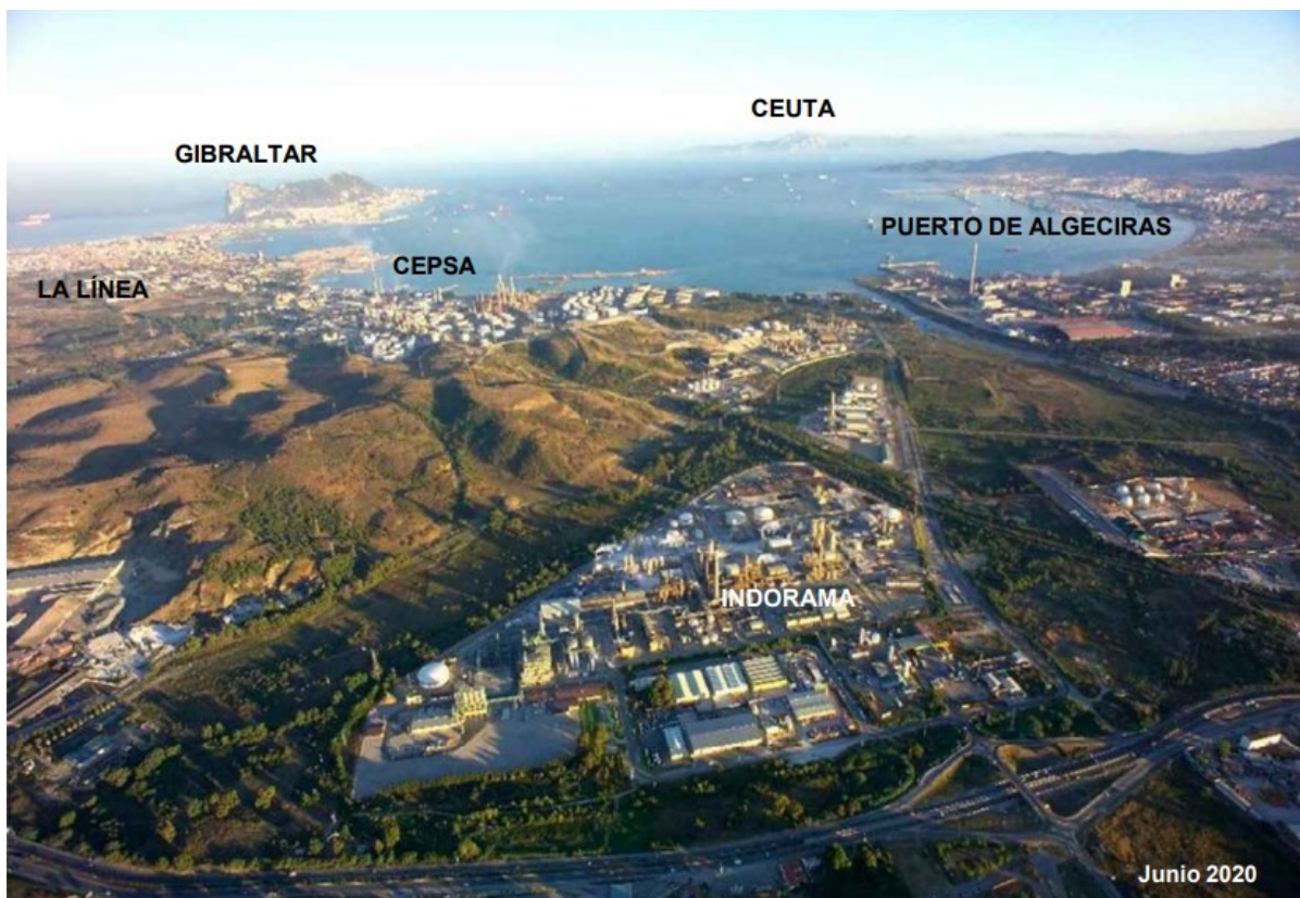
Ilustración 2. Entorno de las instalaciones de Indorama Ventures Química, S.L.U.
