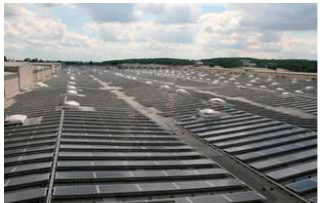
แผงโซลาร์เซลล์ติดตั้งที่โรงงาน Trevira
