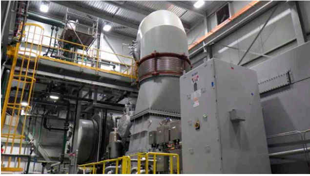
โรงงาน Indorama Ventures PTA Montréal (IVPTA) ได้ติดตั้งและใช้งานเครื่องผลิตไฟฟ้ากังหันไอน้ำ (Turbo-Generator) ซึ่งช่วยลดการใช้ไฟฟ้าในบริษัทได้ร้อยละ 20 กังหันจะผลิตกระแสไฟฟ้าจากไอน้ำได้โดยเฉลี่ย 6,700 กิโลวัตต์ เทียบเท่าการใช้งานในครัวเรือน 2,000 หลัง โครงการนี้ทำให้ IVPTA สามารถเพิ่มประสิทธิภาพด้านพลังงาน เพื่อลดค่าใช้จ่ายในกระบวนการผลิตและรักษาความสามารถในการแข่งขันในตลาด PTA ได้
